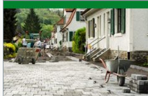
Das JASTO Rustikal-Pflaster wird in ungebundener Bauweise auf einer Bettungsschicht aus Basaltsand verlegt.
