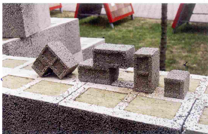
Mit Z-Steinen, die „automatisch“ ineinandergreifen, entsteht ein „sauberes“ Mauerwerk
