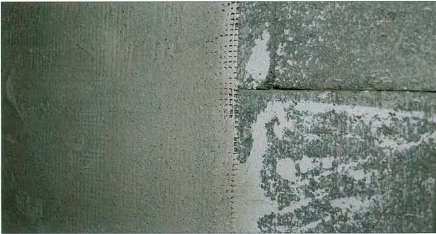
Eine zusätzliche Putzbewehrung aus Armierungsgewebe sorgt für erhöhten Risswiderstand.
