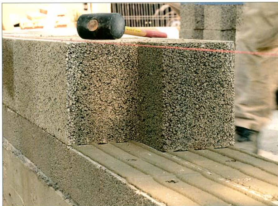
Leichtbeton-Mauerwerk hat eine raue, offenporige Struktur.
