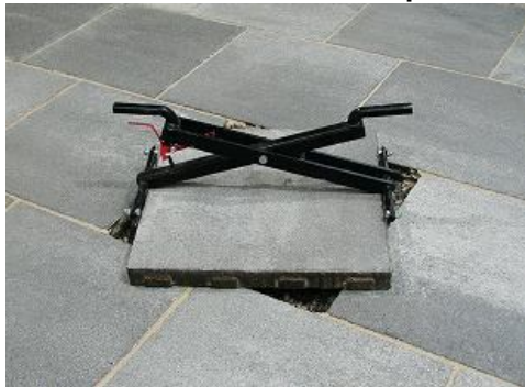
Abb. Verlegung mit spezieller Castilia Verlegezange
